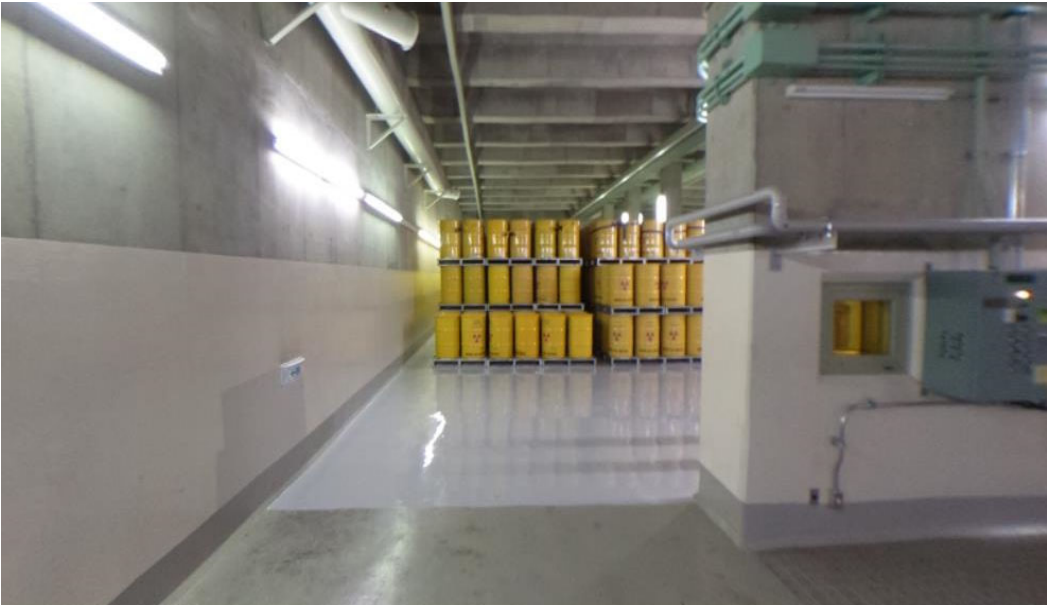
当該エリアの入口付近現場写真
