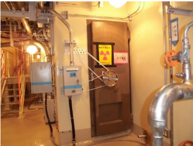
当該エリア入口付近の現場写真
