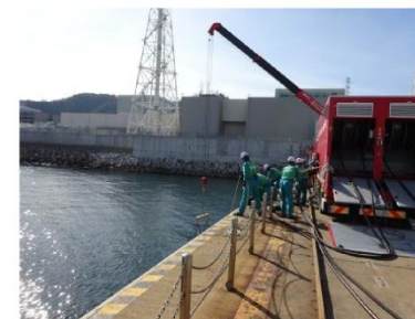
水中ポンプ設置の状況
