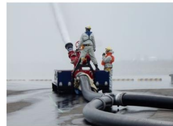
放水砲による放水 (直状放射)
