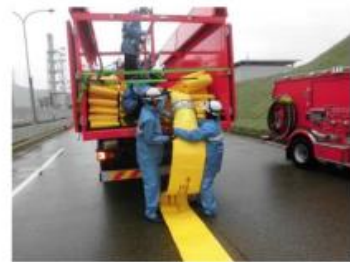
ホース設置の状況
