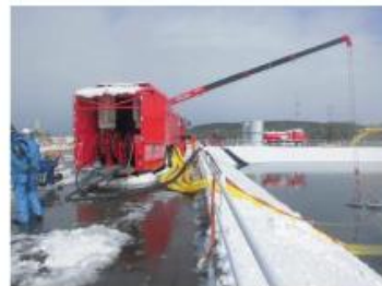
水中ポンプ設置の状況
