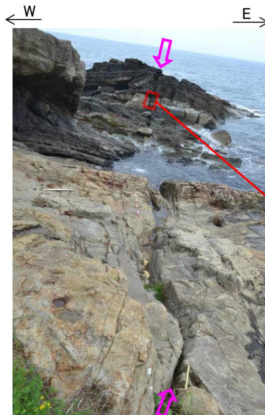
写真6 ナズナ鼻東岸 断層(固結)部
