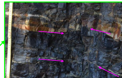
写真5-2 断層(固結)部近接写真(1)
