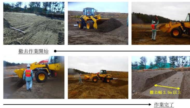
第 8 図 土砂撤去検証の写真
