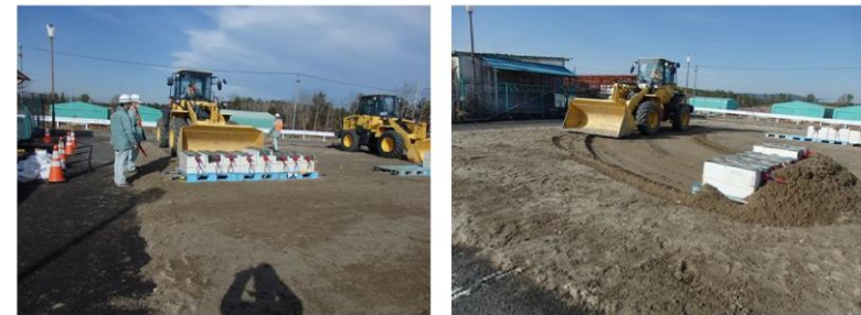
第6図 がれき撤去検証の写真
