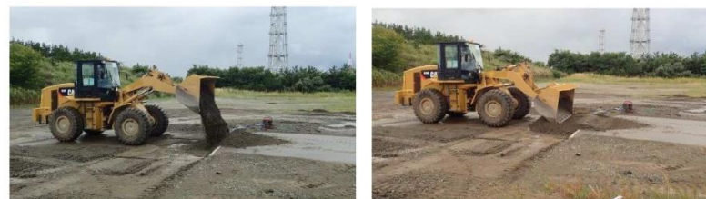
段差復旧状況①
