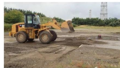
段差復旧状況③
