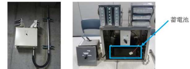
消火用非常照明 (壁掛け型) の設置例
