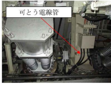
機器へのケーブル取合状況 (主蒸気内側隔離弁との取合)
