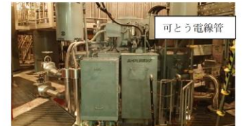
機器へのケーブル取合 (原子炉再循環ポンプ用電動機との取合)
