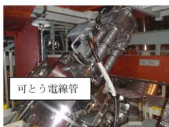
機器へのケーブル取合 (主蒸気内側隔離弁との取合)
