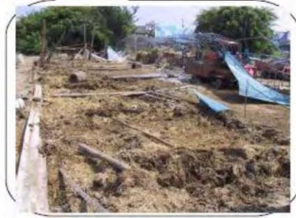
牛舎の屋根東方向、柱・トタン板は西方向に飛散している
