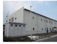
④-1 屋根, 外壁
