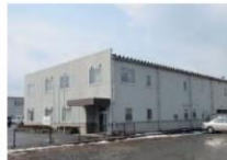
④-10 屋根, 外壁
