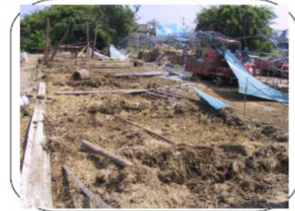
牛舎の屋根東方向、柱・トタン板は西方向に飛散している
