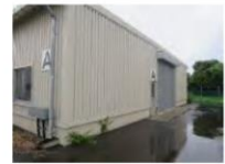
⑤-13 屋根, シャッター
