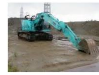
③-14 建設重機 (バックホー)
