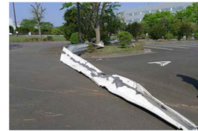
飛散した鋼板製屋根材
