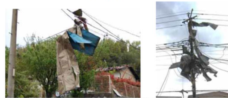
電線等に引っ掛かった飛来物 (鋼板製屋根材)
