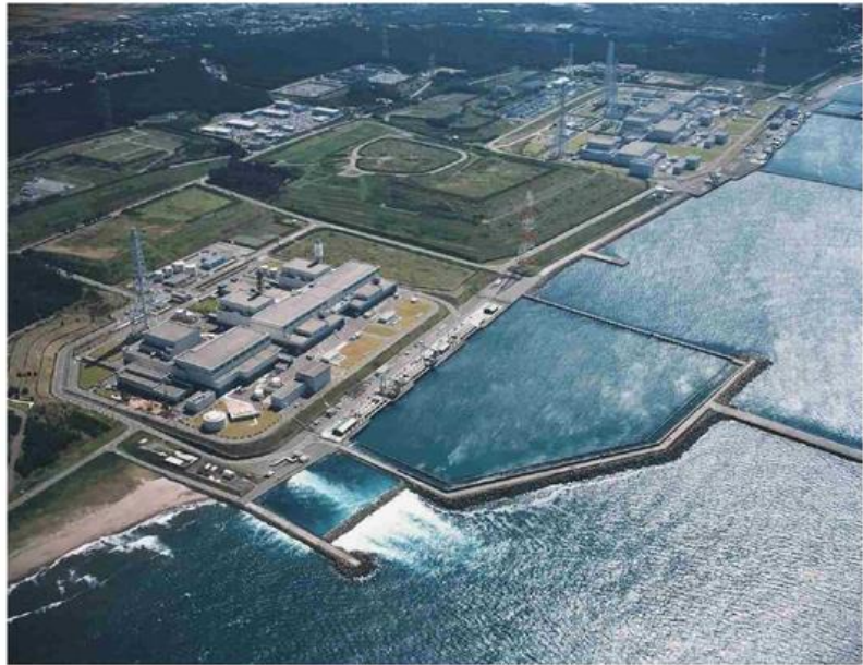
第 1.2-2 図 柏崎刈羽原子力発電所全景(右から 1~4, 7~5 号炉)
