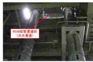
原子炉補機冷却海水系配管貫通部 (天井貫通) 現場状況
