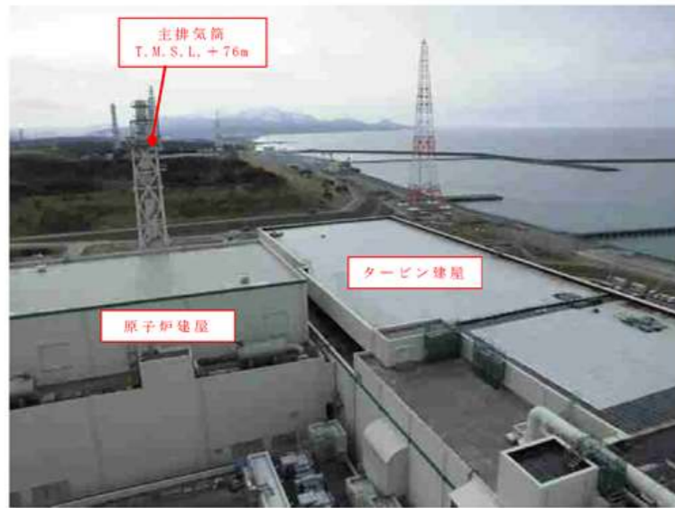
第4.3-2図 津波監視カメラ設置位置
