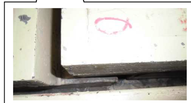
水の流出を考慮する平板間の隙間
