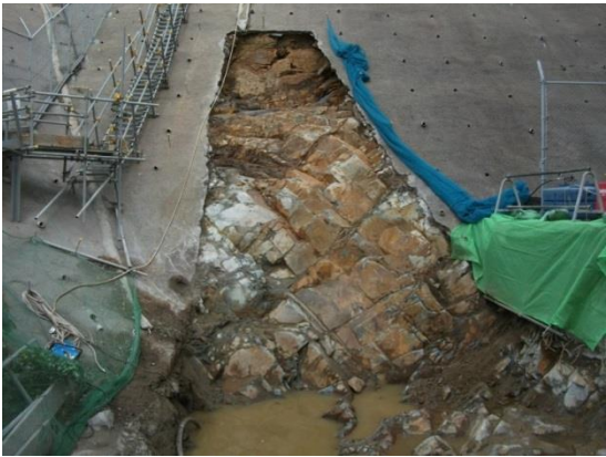
防波壁東端部 岩盤露出状況
