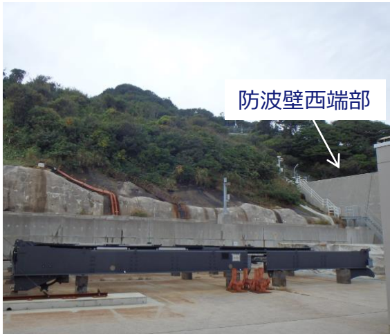
防波壁西端部 状況写真
