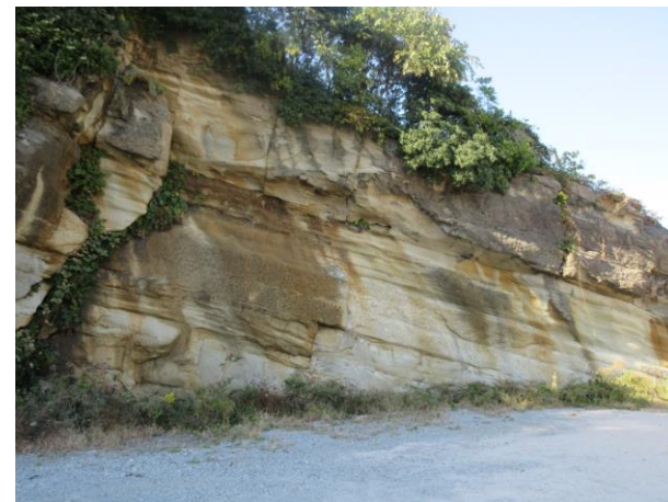
P5 開削面露頭 火山礫凝灰岩～凝灰岩 C M ～C H 級
