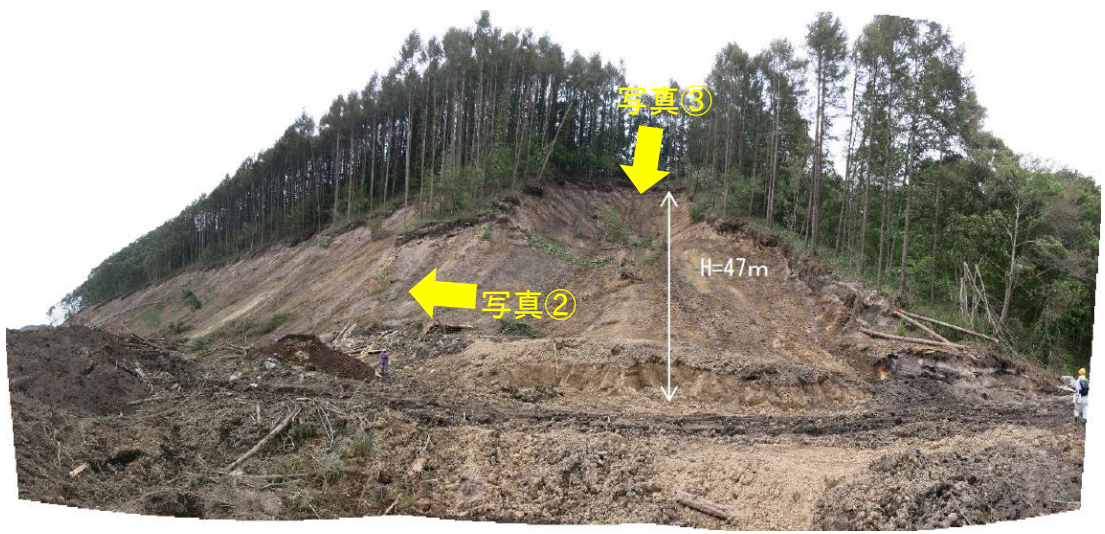
写真① 北海道厚真町吉野地区の斜面崩壊状況
