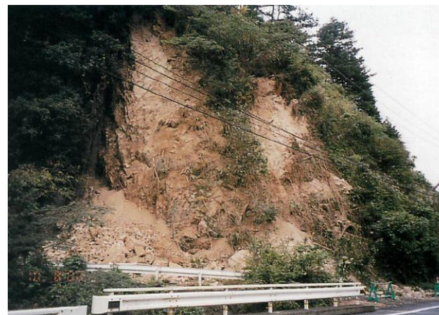
花崗岩斜面の崩壊
