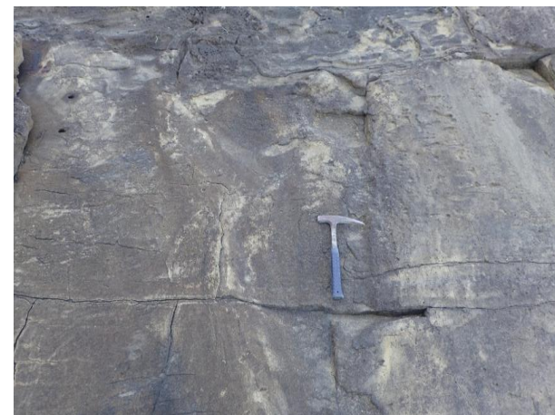
P2 防波壁(西端部) 火山礫凝灰岩 C_H 級
