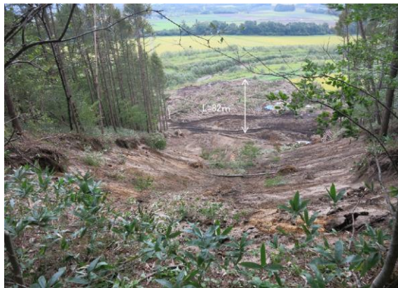
写真③ 崩壊斜面の頭部状況
