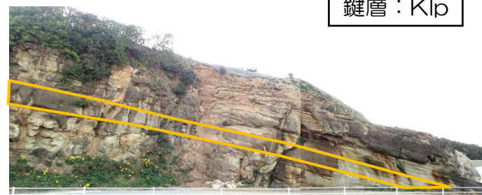
開削面露頭写真(2019年11月6日撮影)
