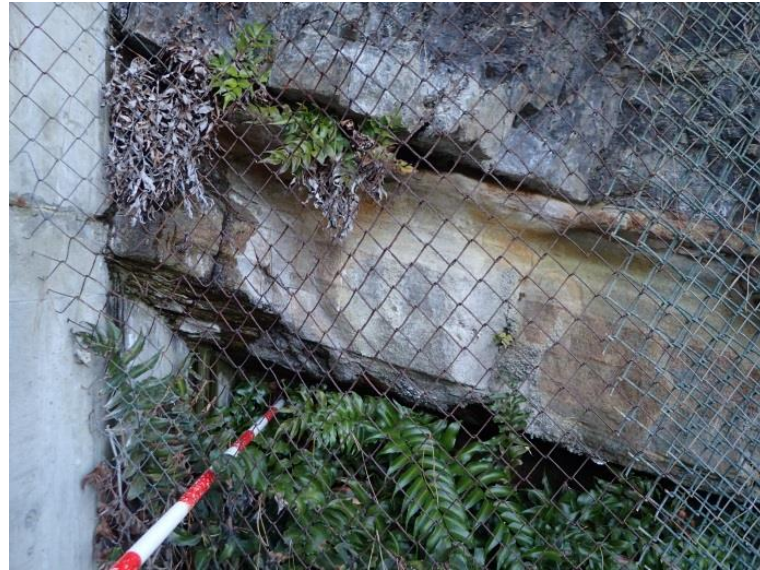
P2 防波扉北側岩着部拡大 岩盤に崩壊するような緩みや高角度亀裂等の顕著な変状は認められない。
