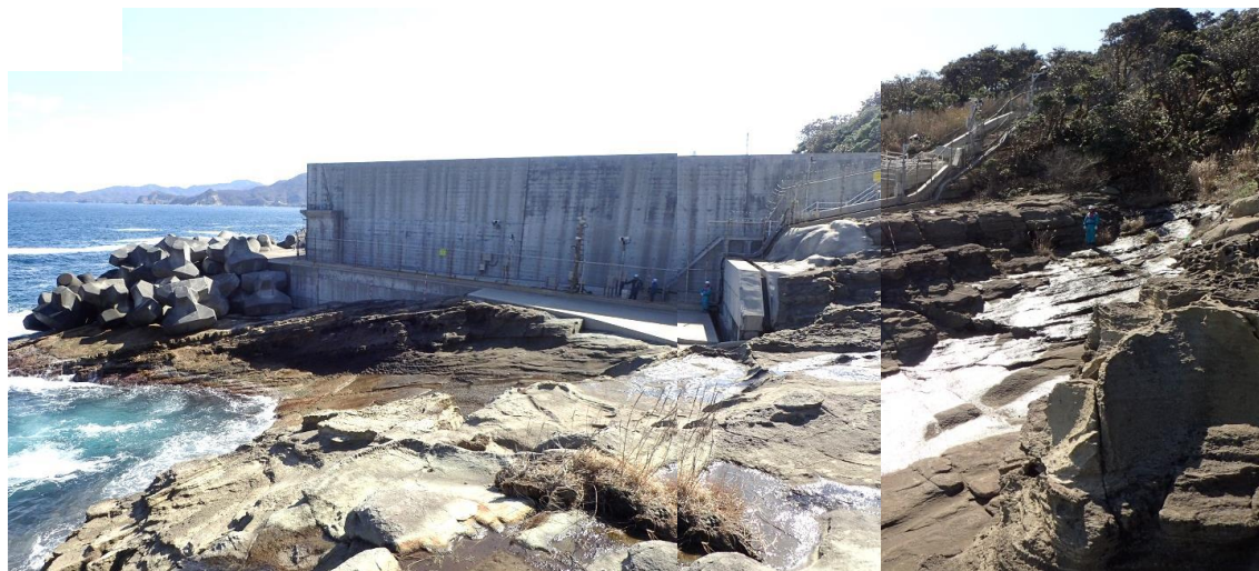
P1 防波壁(西端部)全景 岩着部は火山礫凝灰岩, C_M \sim C_H 級岩盤からなる。
