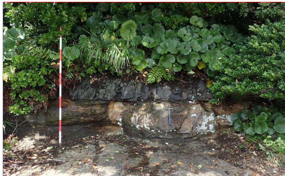
P2 斜面端部 斜面端部は黒色頁岩・凝灰岩の互層, C H 級である。
