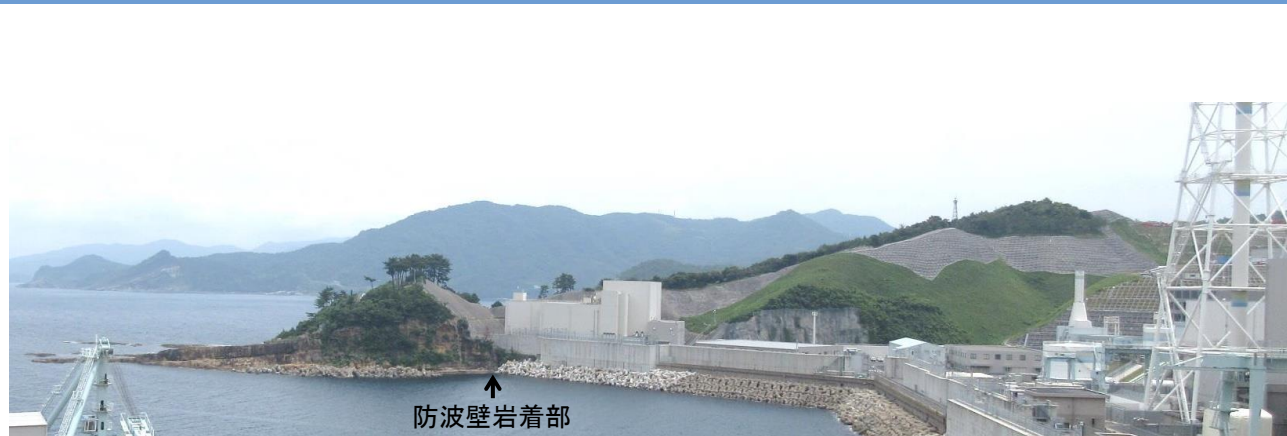
P1 防波壁(東端部)全景 岩着部は尾根の先端を開削した法面に位置する。
