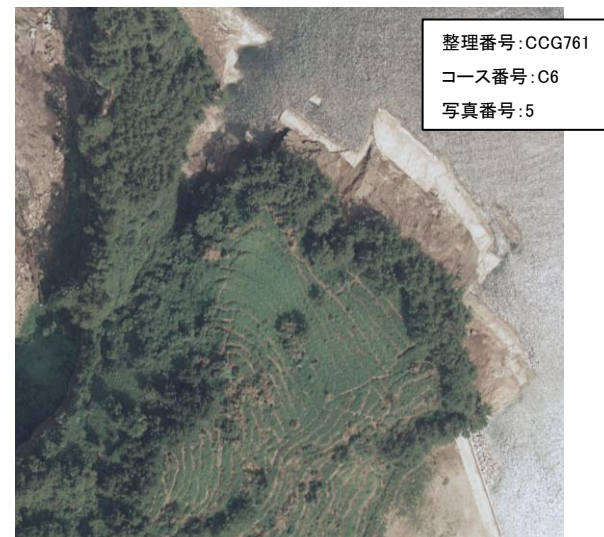
防波壁(西端部)周辺の空中写真 撮影縮尺: 1万分の1, 1976年撮影
