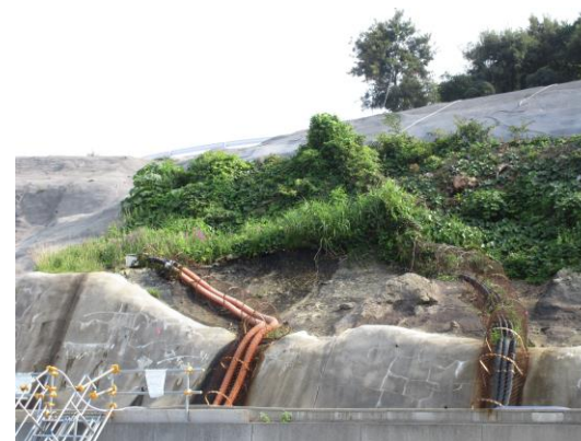
P2 斜面末端部の露頭 礫質土及び凝灰岩(2019年7月4日撮影)
