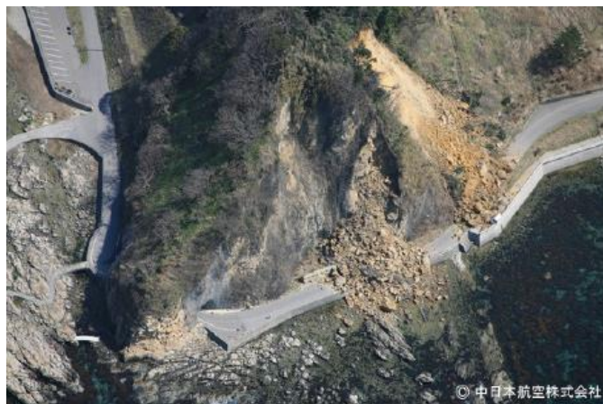
写真2:塊状の砂岩における径数mの多数の岩盤崩壊
