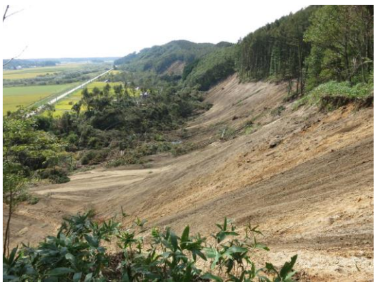
写真② 崩壊斜面の頭部状況
