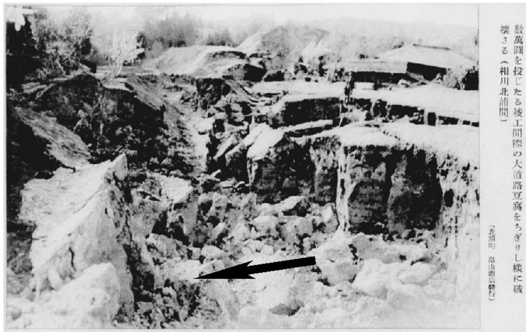
写真一 3 男鹿地震による北浦地区の地すべり —当時の絵はがきより— (阿部ほか(2006)より引用)
