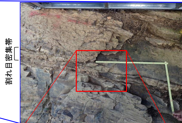
凝灰岩露頭写真
