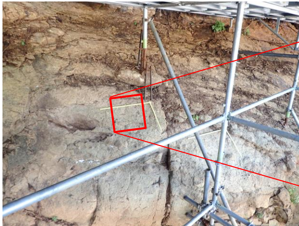
開削面露頭 標高19m付近 (2019年10月24日撮影)
