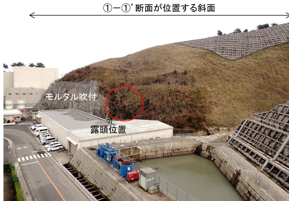
①-①' 断面 斜面全景(2020年1月10日撮影)
