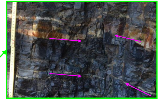
写真5-2 断層(固結)部近接写真(1)
