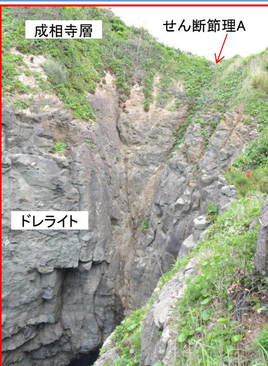
写真7-1 NNW-SSE系のせん断節理
