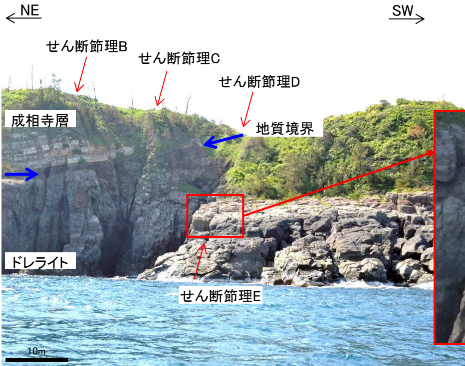
写真9 海側より南を望む
