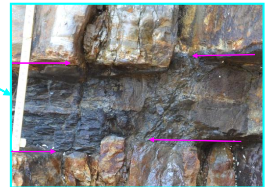
写真5-3 断層(固結)部近接写真(2)
