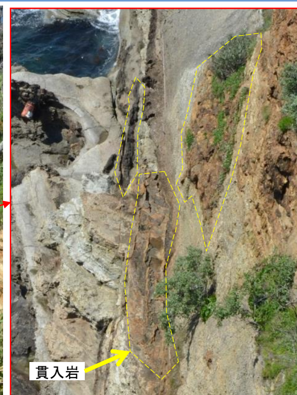
写真2-1 宮崎鼻西岸岩壁
