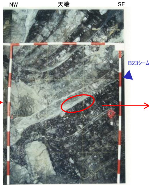
試掘坑写真(平成15年撮影) ○ サンプル位置
