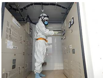
直流給電車での作業
