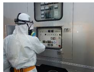
高圧発電機車での作業
