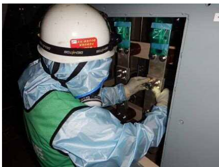
ボルトリンク接続作業
