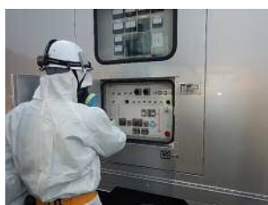
高圧発電機車での作業
