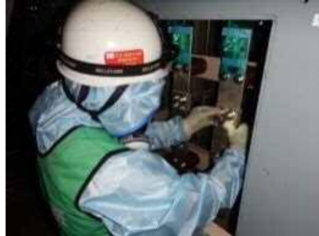
ボルトリンク接続作業
