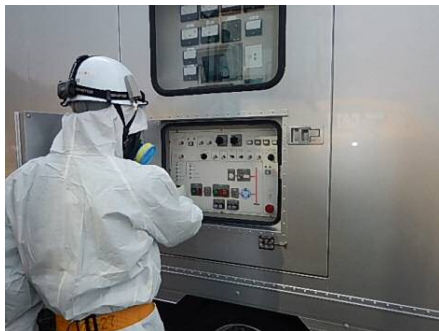
高圧発電機車での作業
