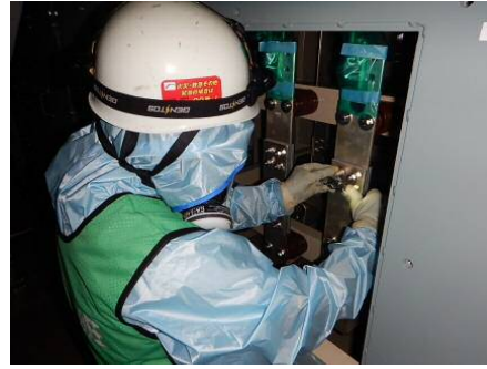
ボルトリンク接続作業
