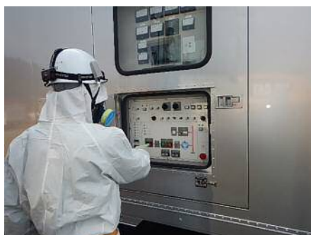
高圧発電機車での作業
