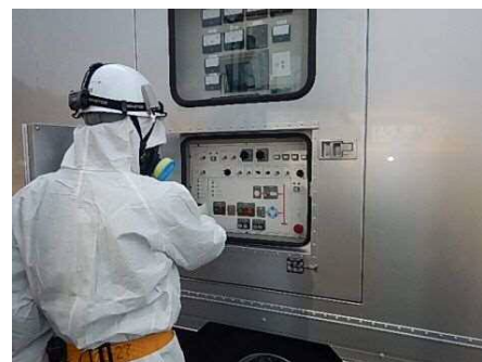
高圧発電機車での作業
