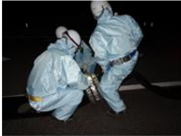
ホース接続作業（夜間）
