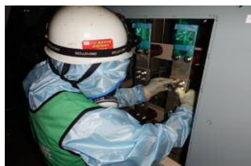
ボルトリンク接続作業
