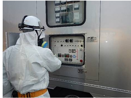
高圧発電機車での作業
