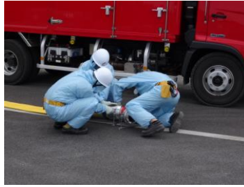
ホース接続作業（昼間）
