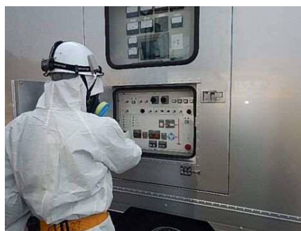
高圧発電機車での作業
