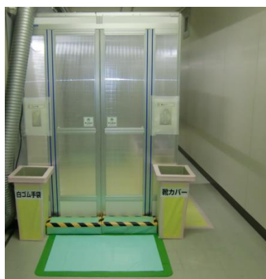
第 6 図 チェンジングエリアの外観
