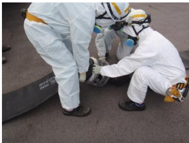
ホース接続作業
