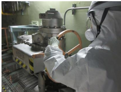
冷却水確保（系統構成）
