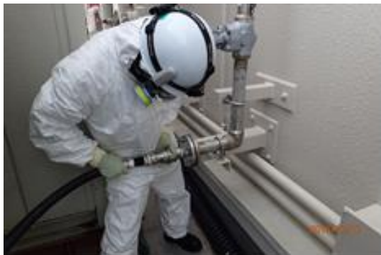
ホース接続作業
