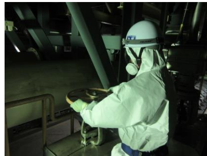
冷却水確保（系統構成）
