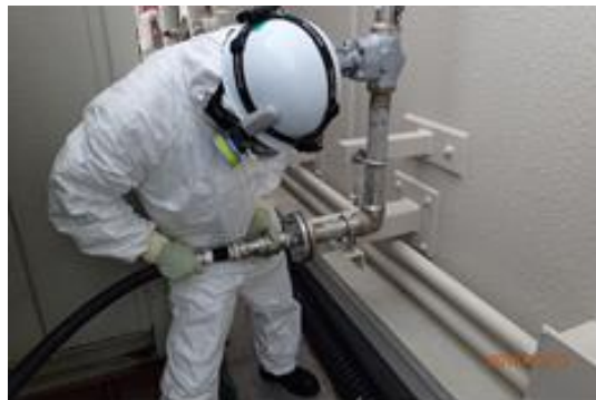
ホース接続作業
