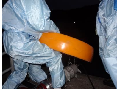
水中ポンプ設置準備（夜間）
