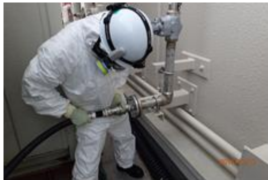
ホース接続作業
