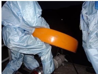
水中ポンプ設置準備（夜間）
