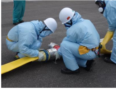
ホース接続作業（昼間）
