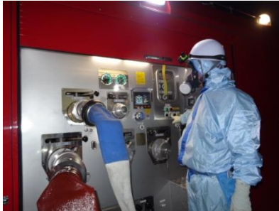
ポンプ起動操作（夜間）
