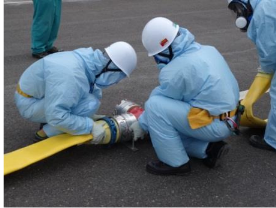
ホース接続作業（昼間）
