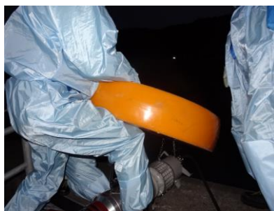
水中ポンプ設置準備（夜間）
