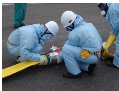
ホース接続作業（昼間）
