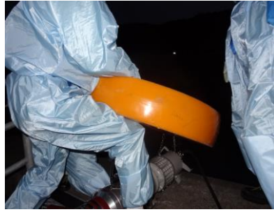
水中ポンプ設置準備（夜間）
