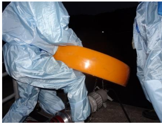
水中ポンプ設置準備（夜間）
