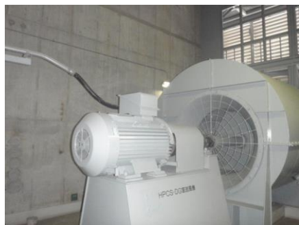
高圧炉心スプレイ系ディーゼル発電機室送風機及び可とう電線管
