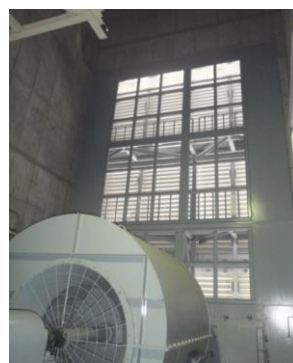
高圧炉心スプレイ系ディーゼル発電機室送風機及び火山灰対策（フレーム）
