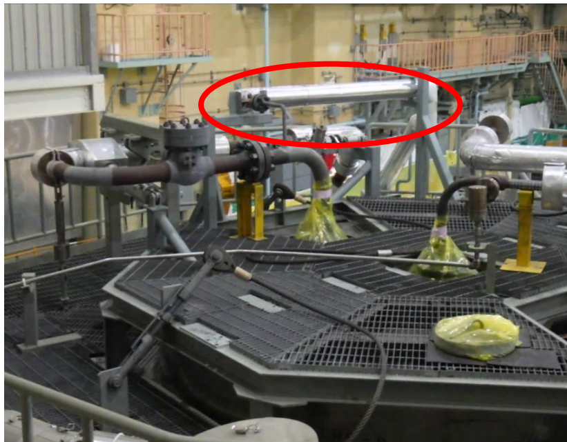
第41-1-6図 ベント配管の設置例
