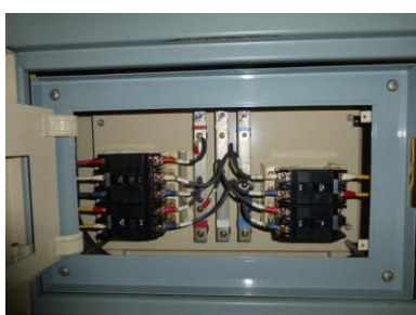
気中遮断器の例 (ブレーカ)
