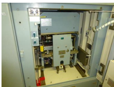
気中遮断器の例 (ロードセンタ)
