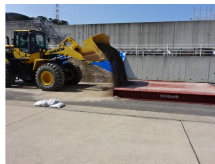
第6図 段差復旧状況
