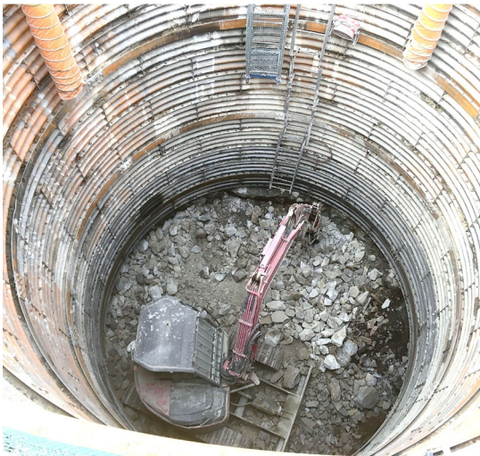
第 7. 4. 2-22 図 掘削状況写真
