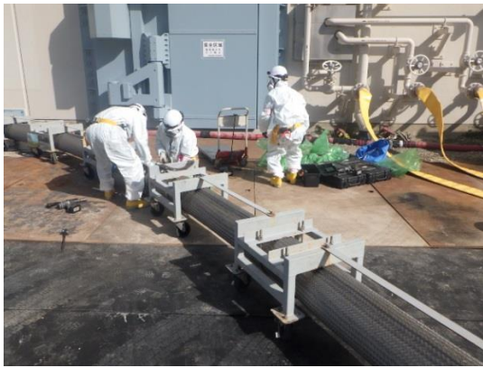
移動式代替熱交換設備 (15m盤 西側接続口付近)
