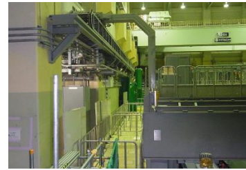
原子炉建物壁面
