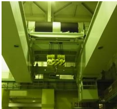
原子炉建物天井クレーン外観
