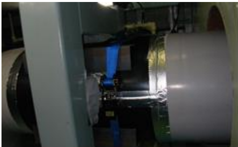
③ 修復完了
