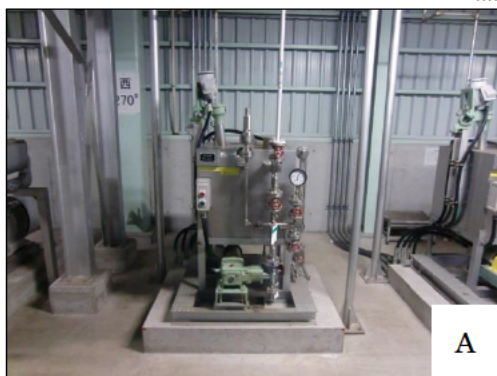
第5図 建物内タンク設置状況 (3号機補助ボイラー建物【濃縮ヒドラジンタンク】)
