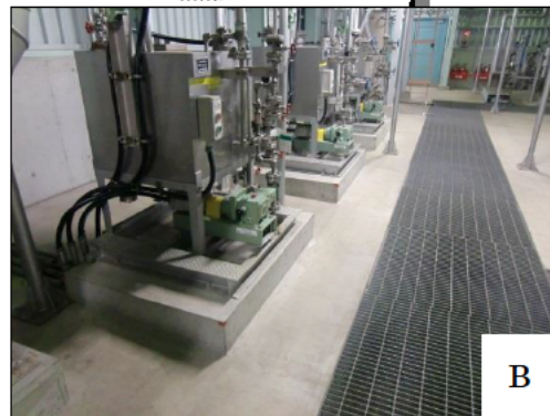
第5図 建物内タンク設置状況 (3号機補助ボイラー建物【濃縮ヒドラジンタンク】)
