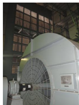
B-非常用ディーゼル発電機室送風機及び火山灰対策（フレーム）
