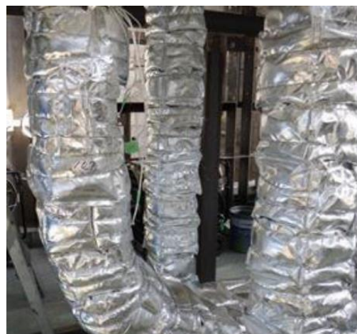
第18図 耐火ラッピングの固定状況
