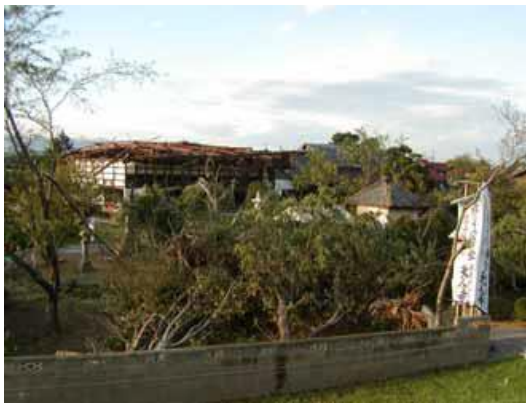
写真1 天神寺外観(南から見る)
