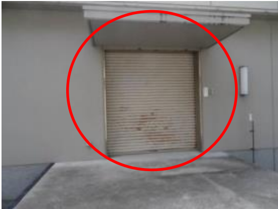
70 危険物屋内貯蔵所東側シャッター
