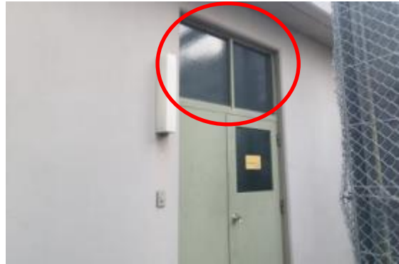
97 2号開閉所ガラス窓
