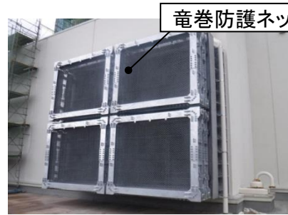
図2 竜巻防護ネットの設置イメージ
