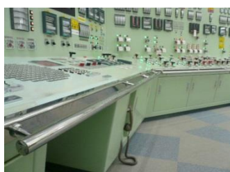
手摺設置状況
