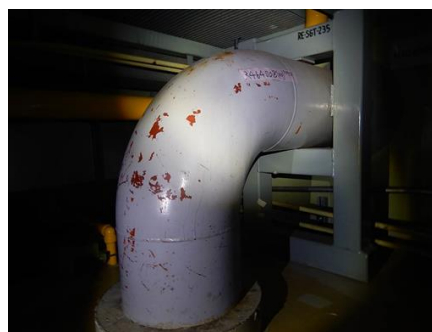
配管補修箇所（可搬型照明使用）
