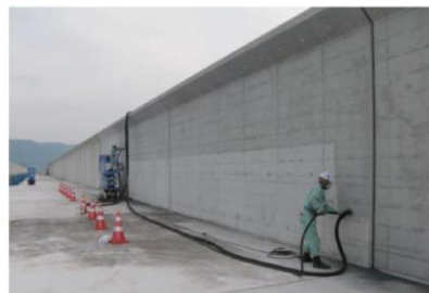
目荒らし施工状況
