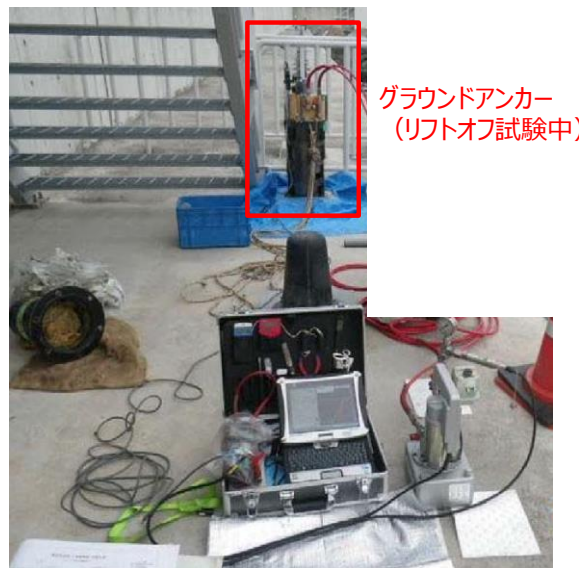
第6-18 図 防波壁（逆T擁壁）定期点検状況 （リフトオフ試験）
