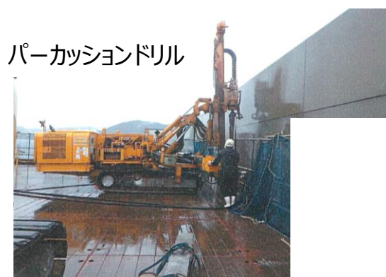
施工状況（削孔工）
