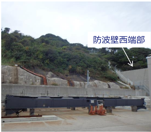
防波壁西端部 状況写真
