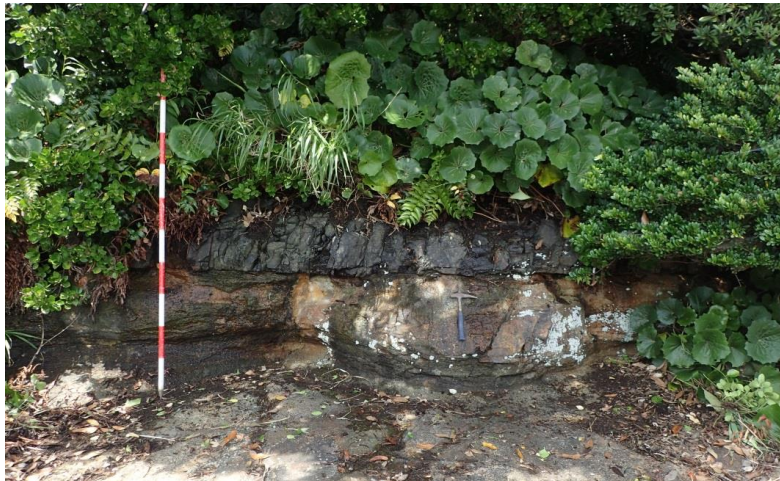
図 2 - 8 ( 5 ) 防波壁 ( 東端部 ) 露頭状況 P5 斜面端部
