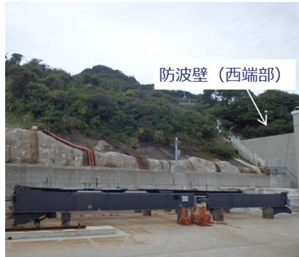
図 2 - 21 防波壁西端部 状況写真
