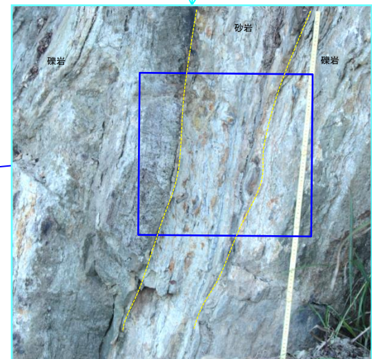
層厚約25cmの砂岩で泥岩を葉片状に挟み，細かな亀裂が発達している。
