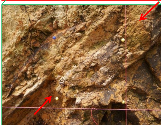
d断層の走向傾斜はN33E60Nであり、部分的に風化変質により軟質化した箇所が認められる。
