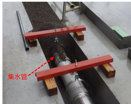
集水管敷設状況
