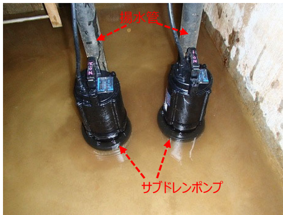
サブドレンポンプ設置状況
