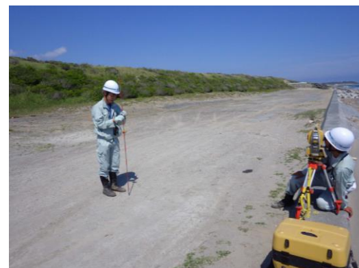
海岸線地形測量実施状況 (陸上部)
