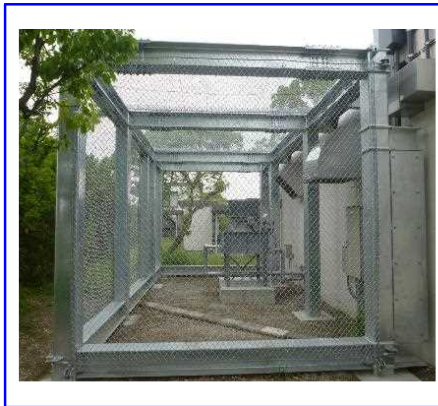
〔工事後の現場〕
