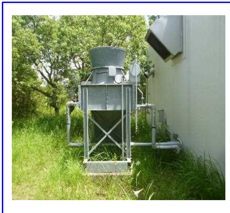
〔工事前の現場〕
