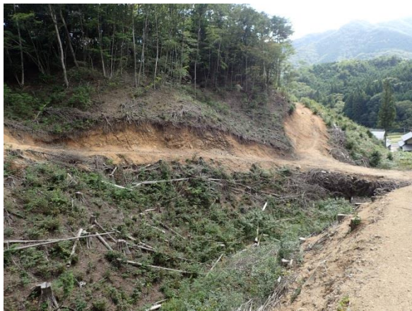
② 林道沿いの全面露頭状況
