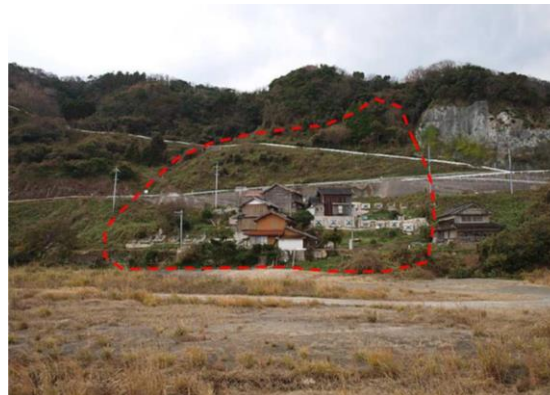
地すべりブロック全景
