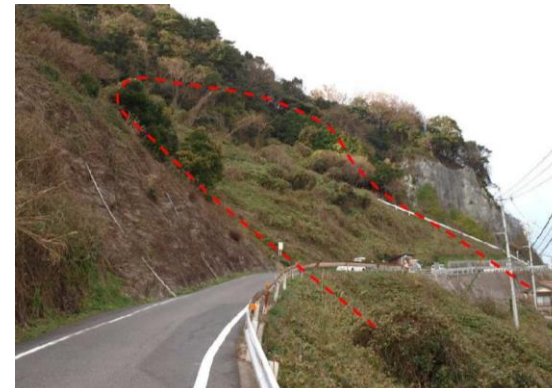
ブロック上部～中央部の斜面状況
