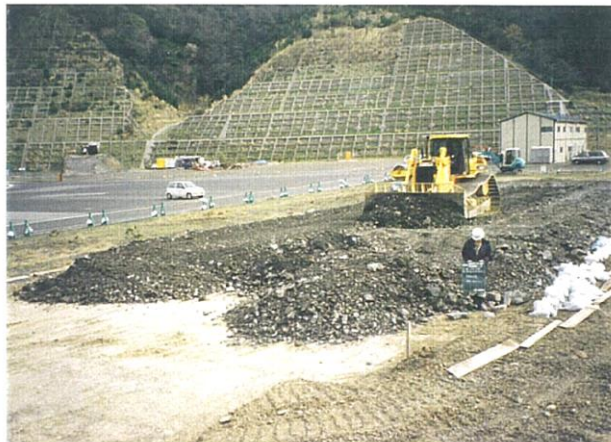
巻き出し整地状況
