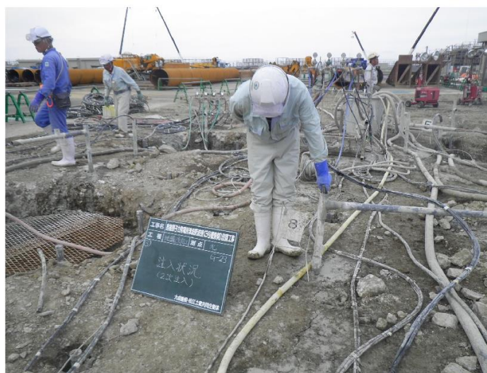
薬液注入工 状況写真(2011年撮影)
