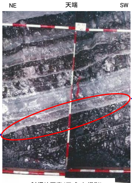
試掘坑写真(平成9年撮影)
