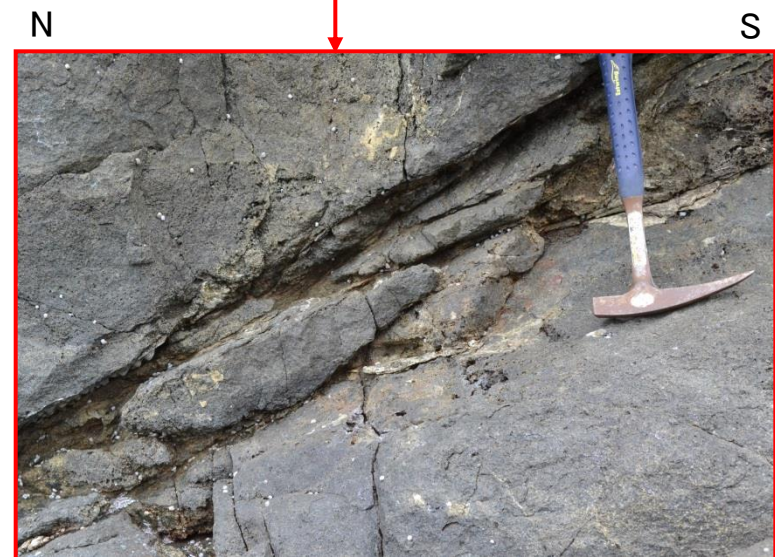
写真11-1 断層(すべり面)近接写真
