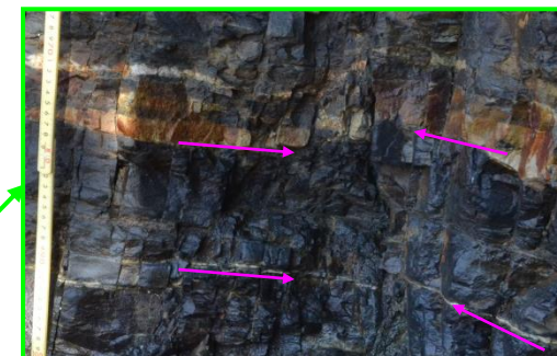
写真5-2 断層(固結)部近接写真(1)
