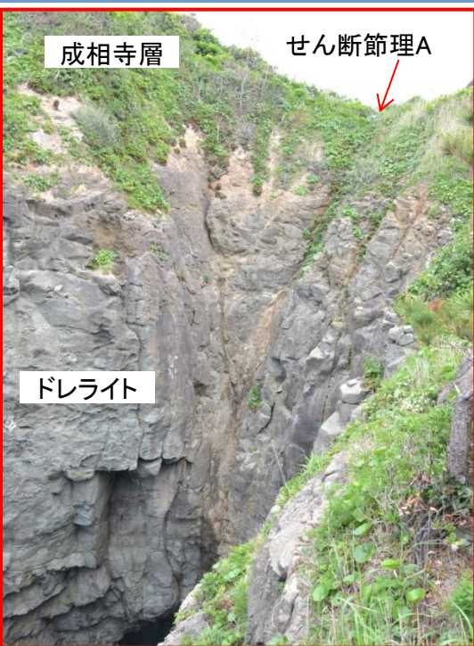
写真7-1 NNW-SSE系のせん断節理
