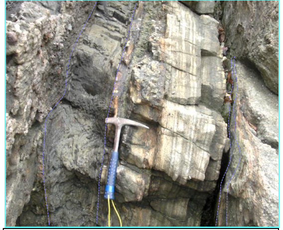
泥岩の層理面及び砂岩との地層境界は固結，密着している。
