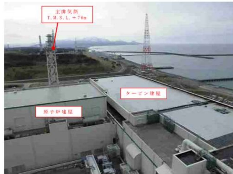
第4.3-2図 津波監視カメラ設置位置
