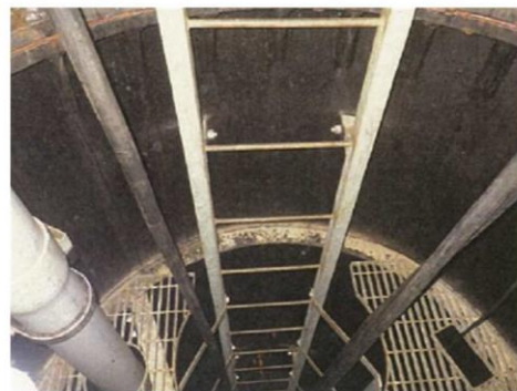
写真B 揚水井戸⑦(中間部) 2017/3/16撮影
