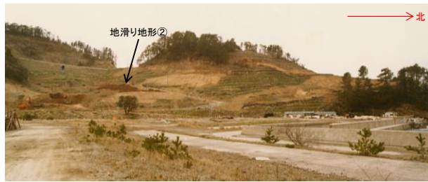
P7 土地造成工事状況写真（置換盛土施工時） 1983年撮影
