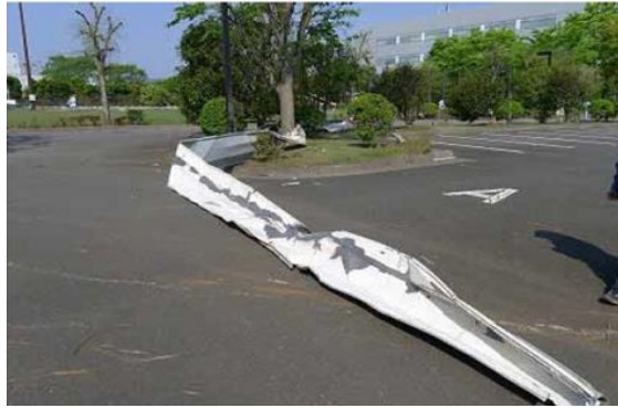
飛散した鋼板製屋根材
