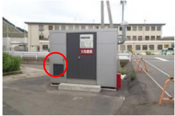
107 危険物屋内貯蔵建物給気用格子
