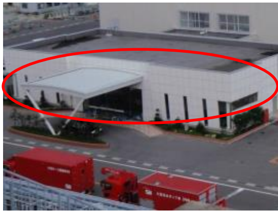
114 出入管理棟南側ガラス窓
