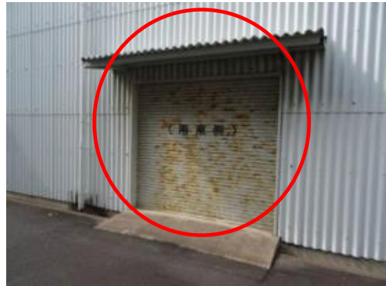
62 2号倉庫南東側シャッター
