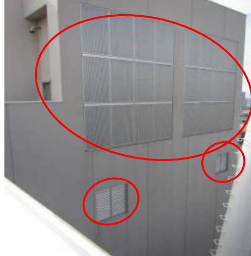
30 T/B空調換気系給気用格子
