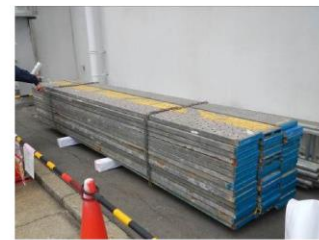
#272 足場材, 足場枠
