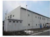
④-1 屋根, 外壁
