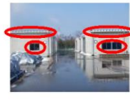
⑤-12 窓ガラス, 屋根
