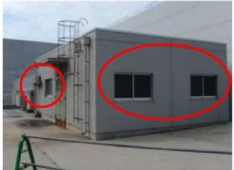
144 2号炉放水路モニタ室東, 南側に面するガラス窓
