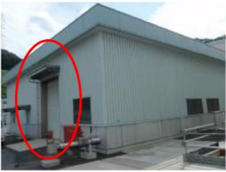
138 給水設備建物東側シャッター
