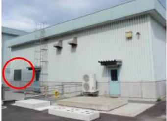
140 給水設備建物西側ガラス窓
