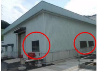
139 給水設備建物東, 北側ガラス窓
